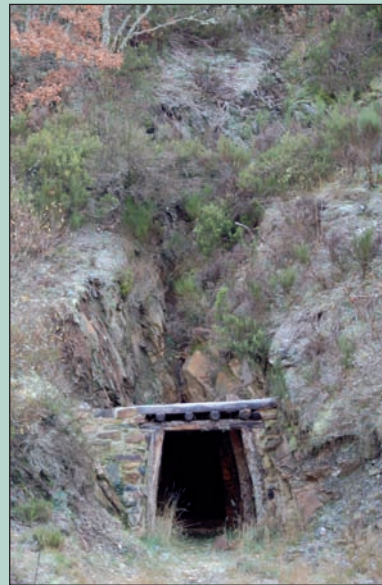
Mina "Carmina", en Pineda de la Sierra, es el principal yacimiento de galena y esfalerita, en un filón de unos 2,5 m de potencia.
